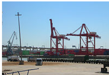
Figura 6. Muelle del Centenario. Concesión de la terminal de contenedores. Grúas de contenedores. En primer término la vía ferroviaria y un tren de mercancías.
